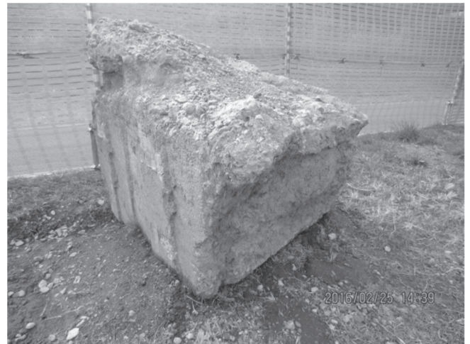
写真 9 旧基礎部の大型四角コンクリートブロック
