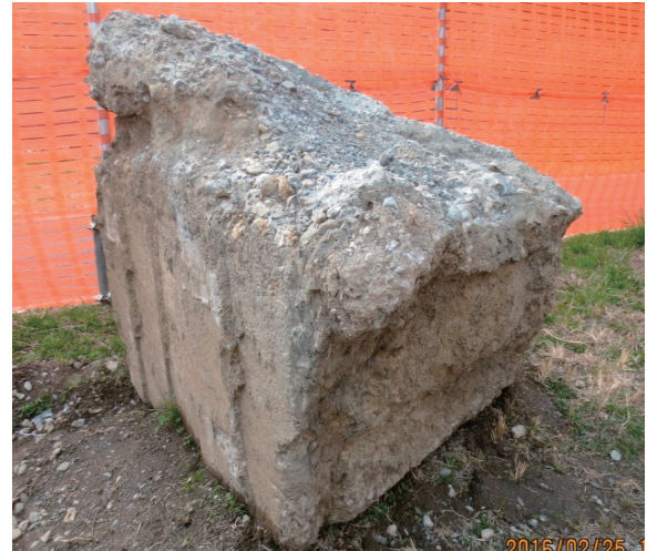
写真31 旧橋脚 P-25 基礎部大型コンクリートブロック
