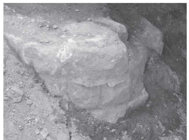
写真5 旧橋脚P-25基礎石組み コンクリートの付着痕
