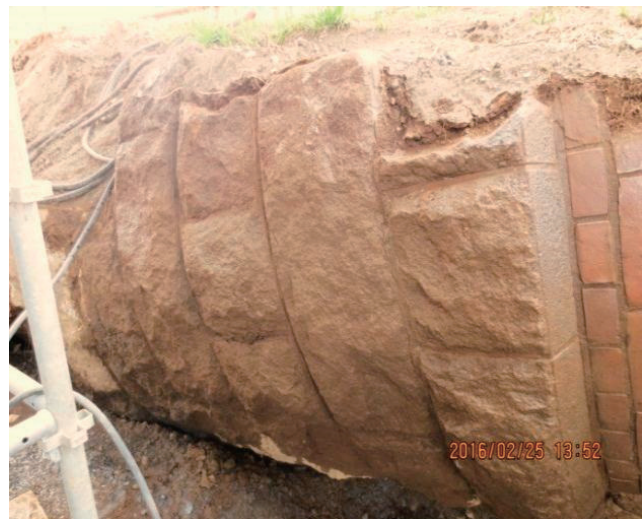
写真33 基礎巻石組（最上部に水切り加工）
