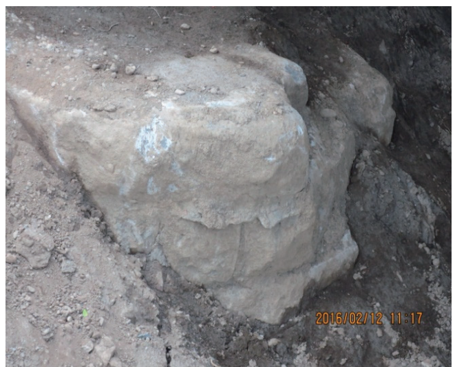
写真 29 旧橋脚 P-25 基礎石組コンクリート付着痕
