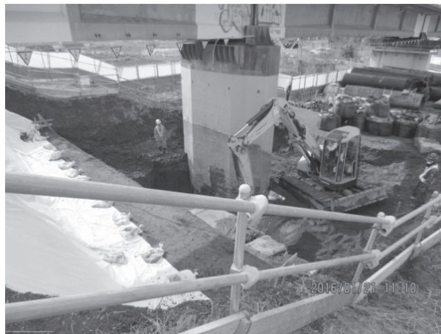
写真1 耐震補強工事
