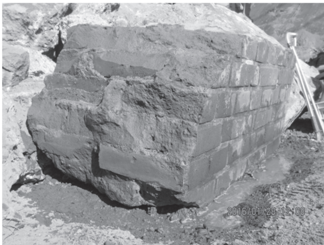
写真3 掘り上げられた旧橋脚P-25 の煉瓦ブロック
