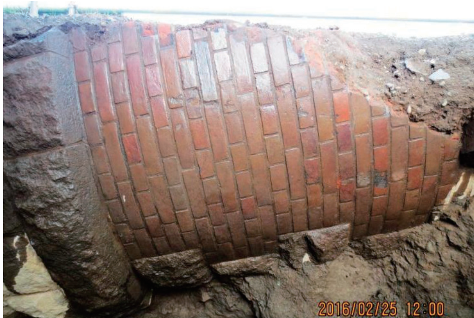
写真34 基礎部巻石組と橋脚部煉瓦積み隅石積み
