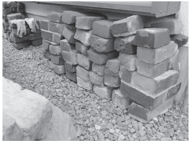
写真17 洗浄が終わった煉瓦単体と小型ブロック
