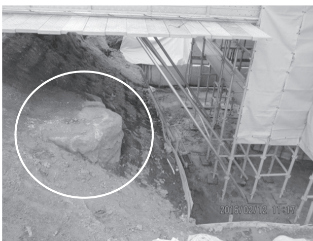
写真4 旧橋脚P-25基礎石組み
