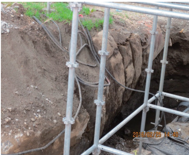
写真32 旧橋脚 P-23 基礎部から転倒
