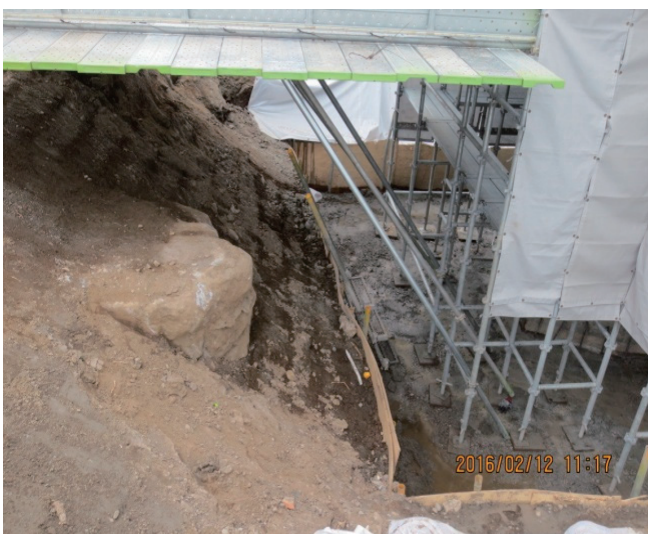
写真 28 左に旧橋脚 P-25 基礎石組み
