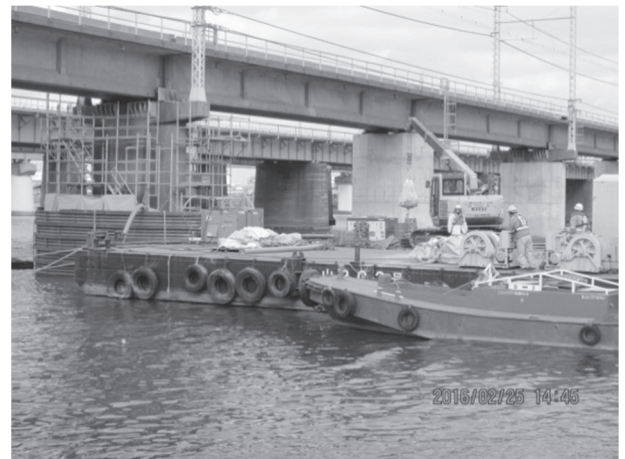
写真13 橋脚 P-18 船台と井筒工法による工事
