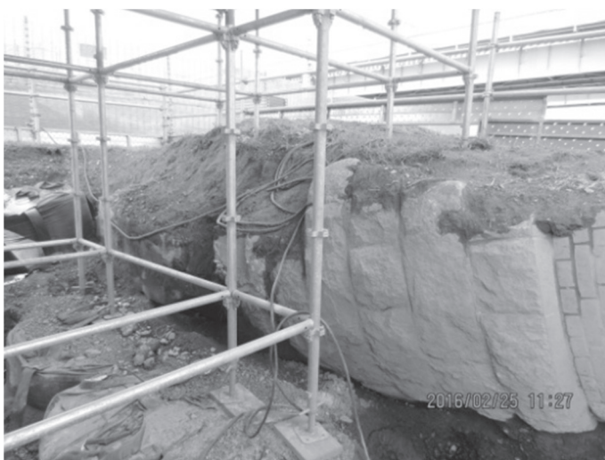
写真 10 旧橋脚 P-23 基礎石組み状態
