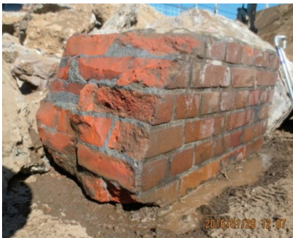
写真 26 旧橋脚 P-25 大形煉瓦ブロック
